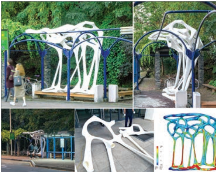
<그림 3> 3D 프린팅으로 제작 비정형 파빌리온 건축 (2018)
